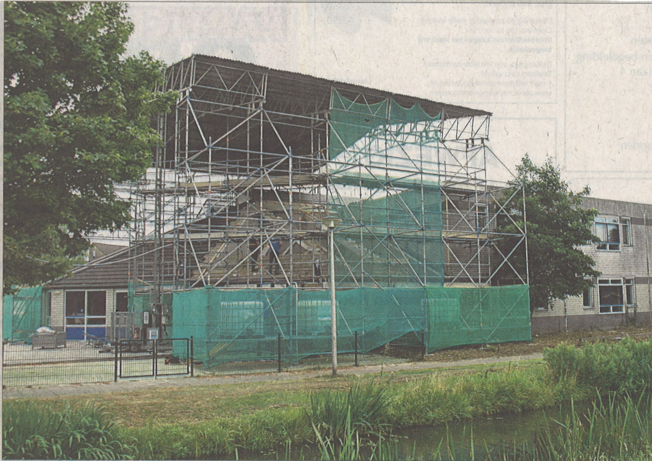
Een dak boven het dak van een deel van basisschool de Hobbit. | Foto: C. v.d. Laan
